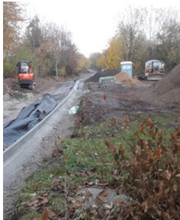
Beginnender Wegebau im Südpark
