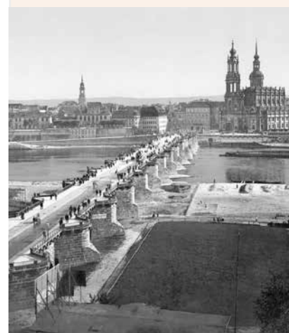
Archiv-Foto vor der Sanierung
